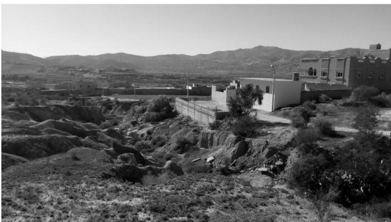
الصورة 04: جانب من التخديد الذي يهدد المنشآت السكنية بمجال الدراسة
